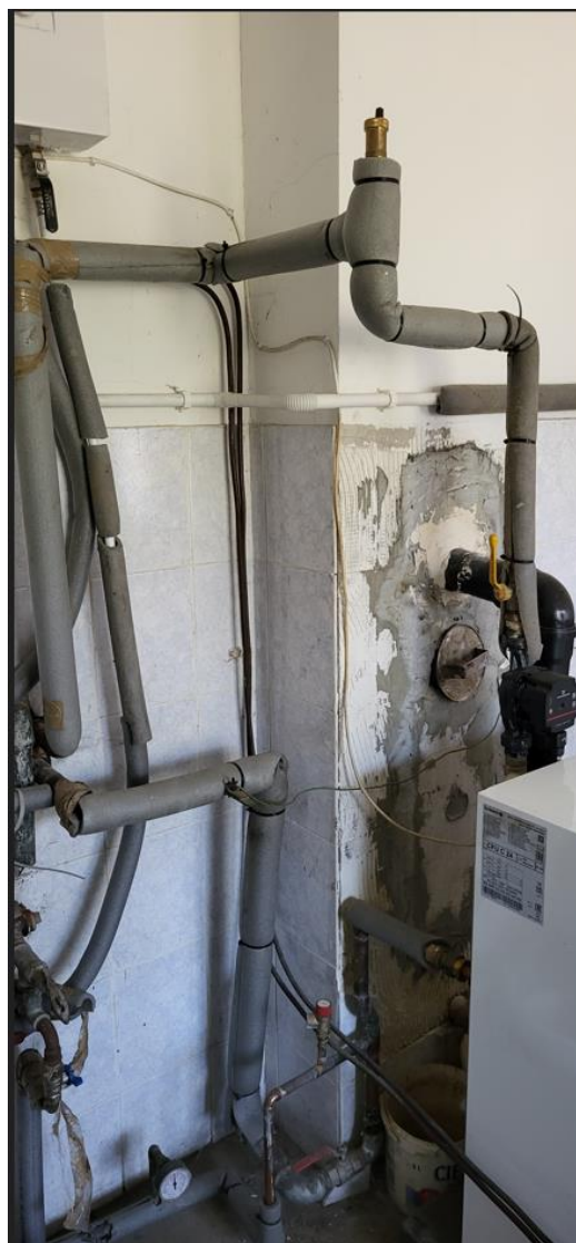
Fot. nr 5 Istniejące elementy instalacji grzewczej
